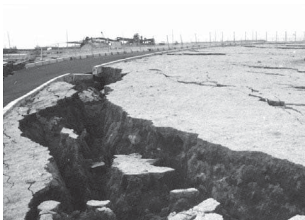
阪神・淡路大震災の被害状況
